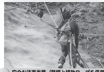
安全な法面作業(親綱と補助ロープを使用)
